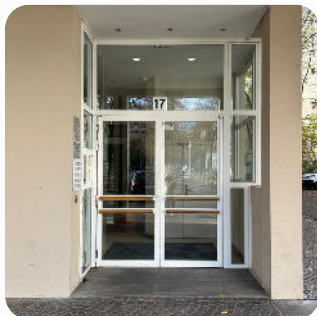
Entrée principale 17 place de l'europe – Lyon 6
